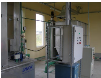
Vaivara OJKK uus, kuid kõlbmatuks osutunud puhastusseade
